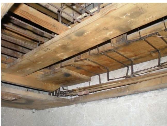
Il vano è piuttosto piccolo e i somieri sono praticamente inaccessibili a causa della meccanica sottostante, particolarmente complicata dai numerosi rinvii. Non vi è facile possibilità di manutenzione ordinaria, né di correzione di eventuali difetti come trasuoni o problemi di intonazione e accordatura di singole canne: l'unico accesso a livello dei somieri è una portella posta sulla parete di fondo del vano, la cui luce è peraltro ingombra da alcune canne di legno.
